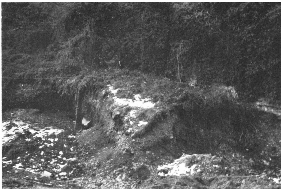
Fig. 1 - Situazione del talus detritico al momento dell'intervento.
