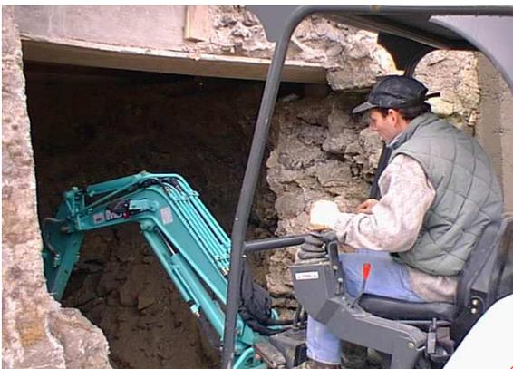
Fig. 8c – L'antico caseggiato durante lo scavo dello scantinato<sup>35</sup>
